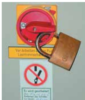
„Gegen Wiedereinschalten sichern“ heißt eine wichtige Sicherheitsregel bei Instandhaltungsarbeiten.
