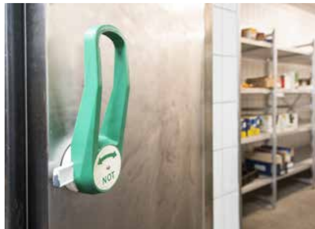
Die Notentriegelung im Inneren des Kühlraums ist jederzeit zu öffnen.
