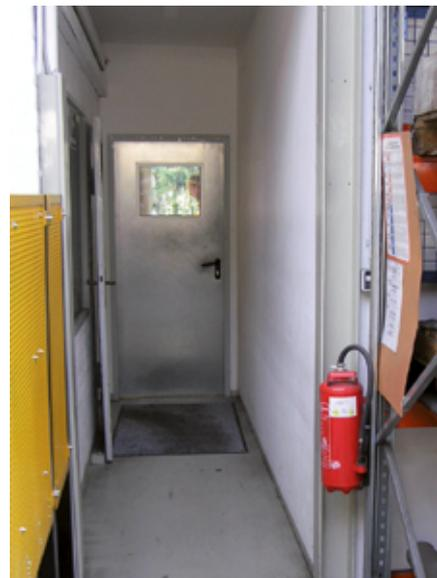
So hängen die Feuerlöscher richtig. Im Bild oben aber ist der Zugang durch abgestellte Teile behindert, das darf nicht sein.
