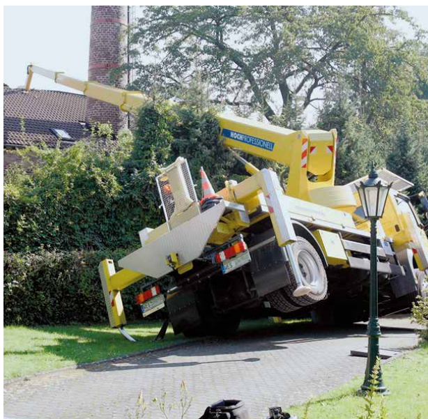
Weil die vordere linke Stütze im weichen Grasboden versackte, kippte das Fahrzeug zur Seite, der Teleskoparm mit dem Arbeitskorb schlug auf das Dach ...
