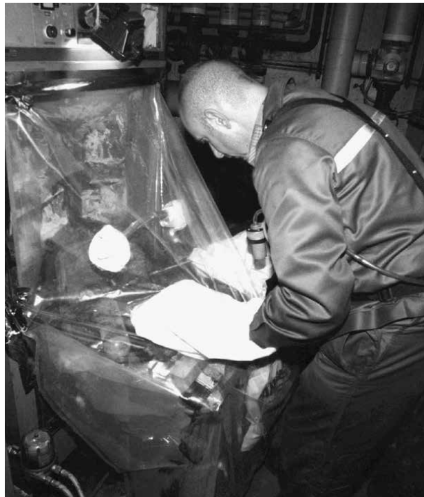
Wenn asbesthaltige Dichtungen mit dem „Glove Bag“ ausgebaut werden, bleibt die Asbestfaserkonzentration im Arbeitsbereich unter 15.000 Fasern/m 3 .
