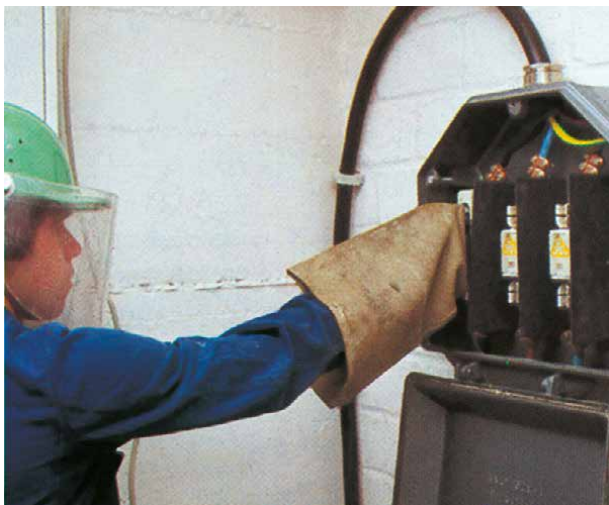
Schutzmaßnahmen beim Einsetzen und Herausnehmen von NH-Sicherungseinheiten
