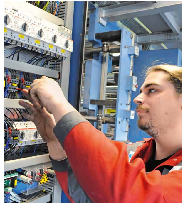
Das darf nur die Elektrofachkraft: Arbeiten am geöffneten Schaltschrank im spannungsfreien Zustand.
