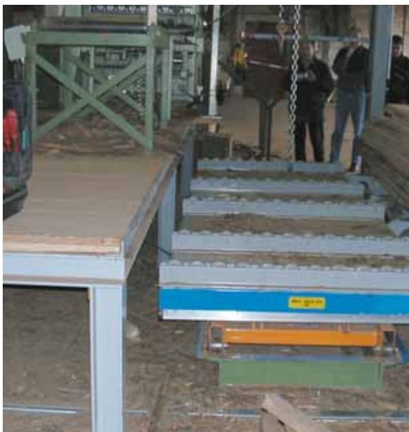
Rechts im Bild der zur tödlichen Falle gewordene Hubtisch, links davon das Arbeitspodest.
