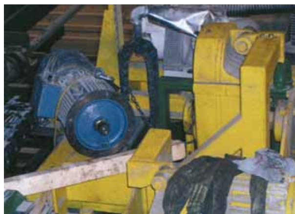
Demontierter Motor mit herabgefahrenem Hubwerk
