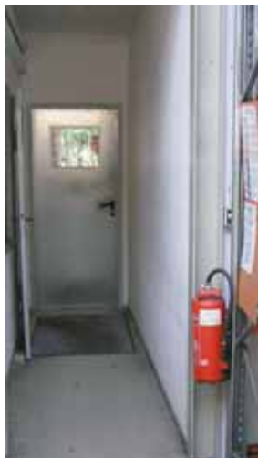
So hängen die Feuerlöscher richtig. Im Bild links aber ist der Zugang durch abgestellte Teile behindert, das darf nicht sein.
