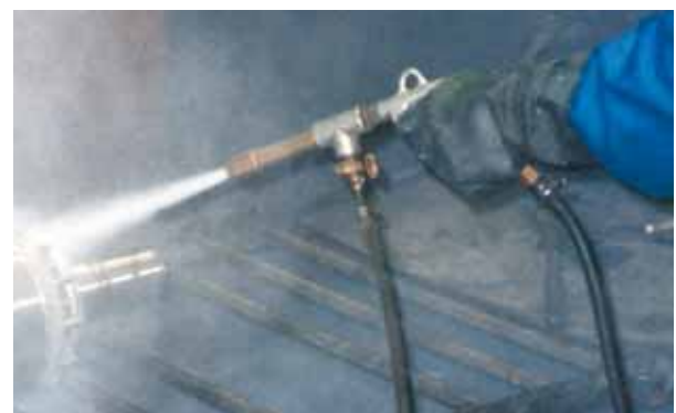
Einsatz eines Hochdruckreinigers
