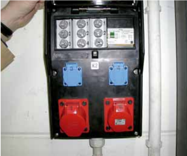
Besonderer Abzweig einer ortsfesten Anlage
