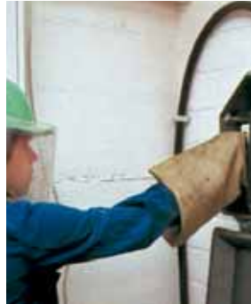
Schutzmaßnahmen beim Einsetzen und Herausnehmen von NH-Sicherungseinsätzen
