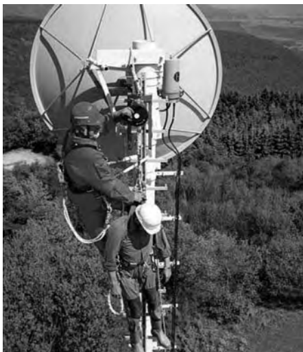
фиг. 18: Пример 1 – спасяване на паднал човек
