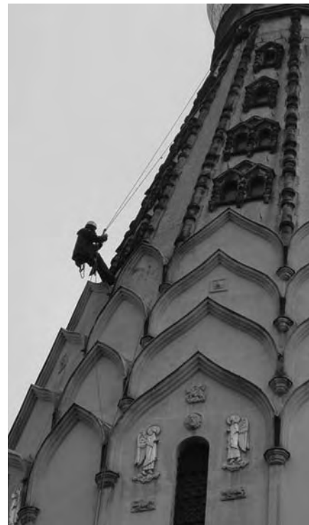
фиг. 7: Работа чрез техники за въжен достъп и позициониране с въжета
