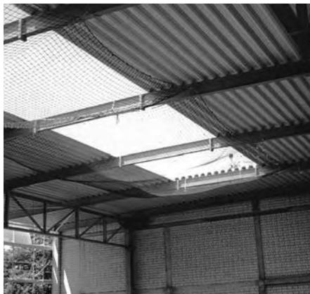
Bild 14: Schutznetze
