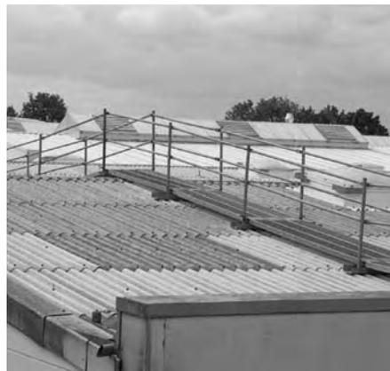
Bild 15: Trittsteife und tragfähige Abdeckung
