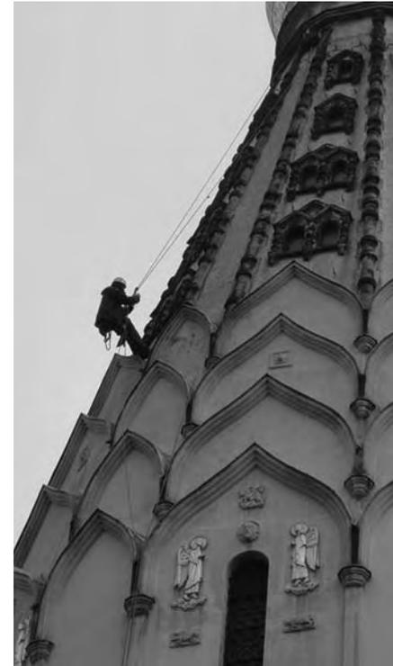
**Bild 7: Seilunterstützte Arbeits- und Zugangsverfahren**
