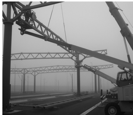
그림 9. 지면에서의 사전 조립 후 고소 작업대를 이용한 설치
