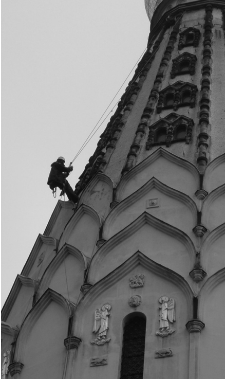
그림 7. 로프를 이용한 작업장소 이동 및 포지셔닝 기술을 사용하는 작업
