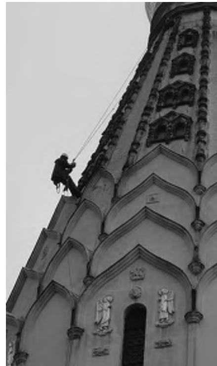
Sl. 7: Radovi kod kojih se koristi tehnika pristupa i pozicioniranja pomoću užeta
