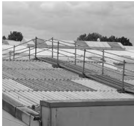
Sl. 15: Pokrovi za raspodjelu opterećenja
