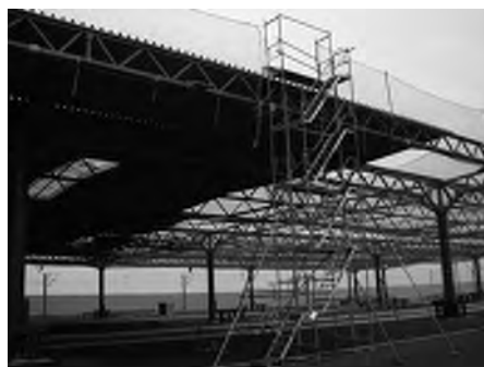
Sl.13: Samostojeće toranjske stepenice
