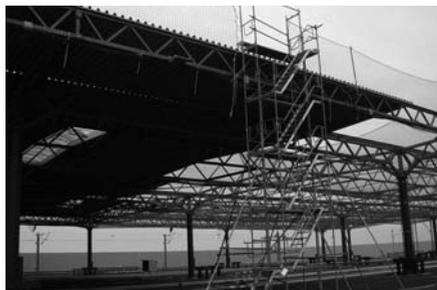
Figura 13: Torre aislada de escaleras de pedestal
