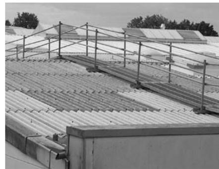
Figura 15: Cobertura resistente al pisar y a las cargas
