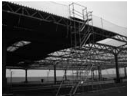
Obr. 13: Volně stojící schodišťová věž
