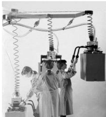
Bild 8: Umsetzen von Lasten mittels Vakuum-Hebegerät
