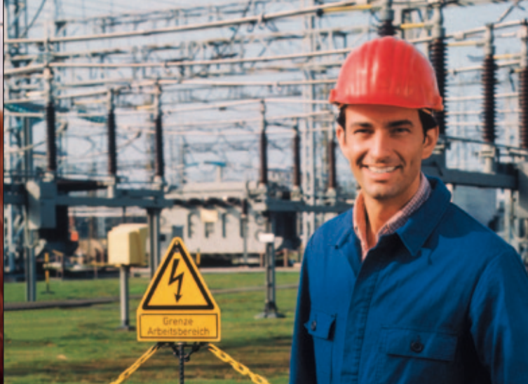
Kennzeichnung des Arbeitsbereiches in einer Freiluftschaltanlage
