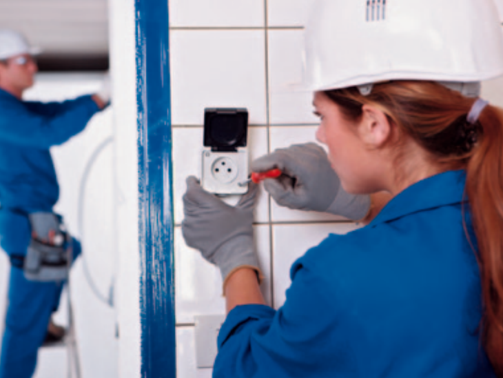
Montage einer Steckdose in einem Sanitärraum
