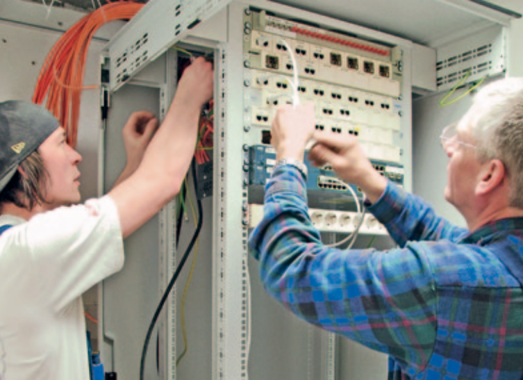
Einziehen von Leitungen an einem Steuerschrank im spannungsfreien Zustand
