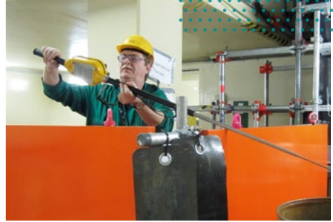
Abschirmen durch Bleimatten
