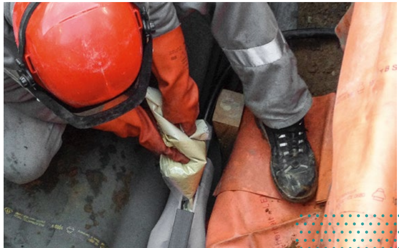
Abbildung 17: Muffengießen mit dafür erforderlicher PSA
