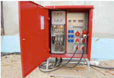
Baustromverteilerschrank
