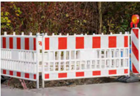
Absicherung einer Grube
