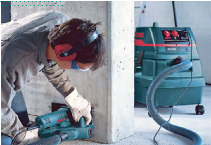
Mauernutfräse mit Staubabsaugung
