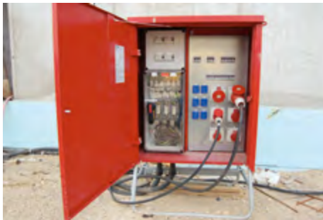
Baustromverteilerschrank
