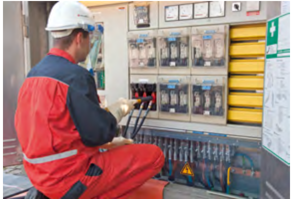
AuS-Tätigkeit: Montage des NH-Steckeinsatzes zum Anschluss eines Notstromaggregats
