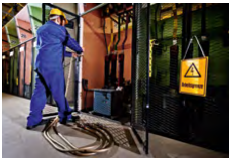
Einlegen der Erdungs- und Kurzschließ- vorrichtung in einer Mittelspannungs- schaltzelle
