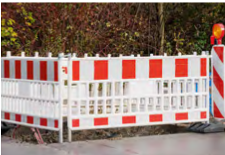
Absicherung einer Grube
