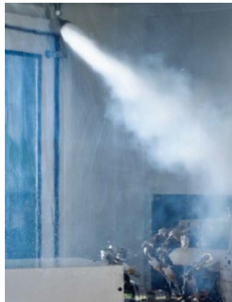
Abb. 37: Löschdüseneinsatz nach Branddetektion
