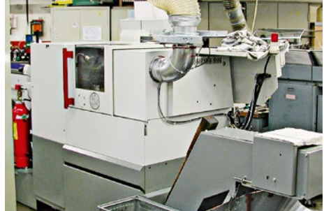
Abb. 36: Maschine mit angebauter Löscheinrichtung und Brandschutzklappe (Schieber) in der Absaugung
