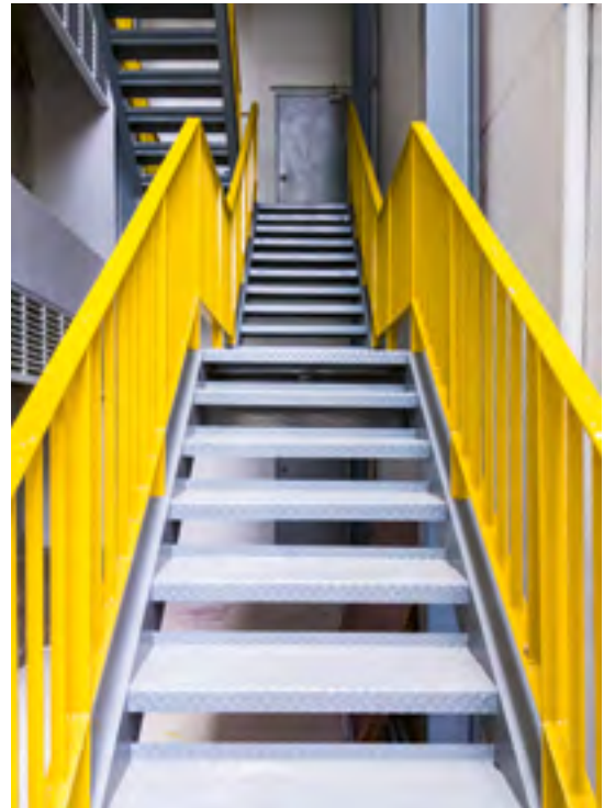
Bei der Gestaltung von Treppen ist auf ausreichend große, ebene, rutschhemmende, erkennbare und tragfähige Auftrittsflächen zu achten.
