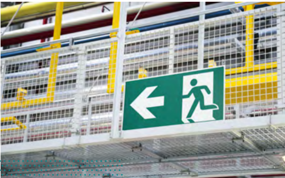
Fluchtwege müssen gekennzeichnet sein.
