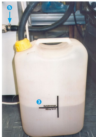
Handbügelplatz – Kleindampferzeuger (KDE) – Abschlammbehälter
