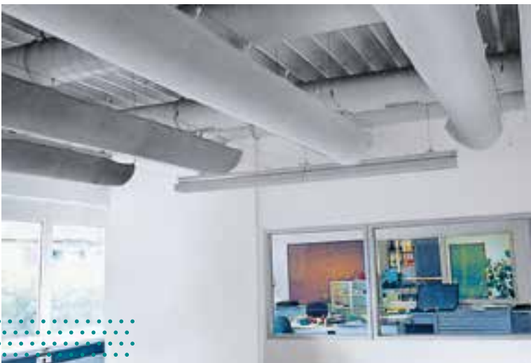
Zugfreie Belüftung durch Gewebeschläuche
