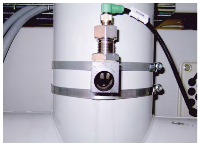
Sensor zur Überwachung der Absaugung
