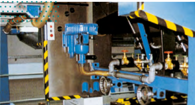
Hervorstehende Maschinenteile müssen gepolstert und mit einer deutlich erkennbaren und dauerhaften Gefahrenkennzeichnung versehen sein
