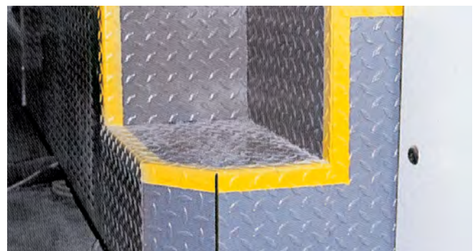
Gut bewährt hat sich die farbliche Kennzeichnung von Podesträndern.
