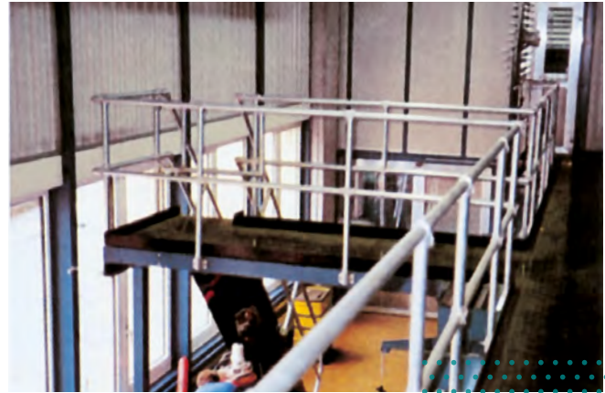
Absturzicherung der Treppe eines Maschinenabstieges durch seitliches Herausziehen des Abgangs
