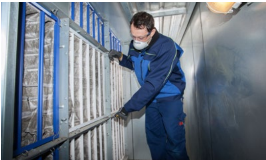
Hygienekontrolle der Luftfilter einer RLT-Anlage
