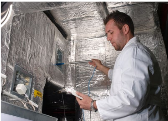
Ermittlung des Luftvolumenstromes in einer Luftleitung
