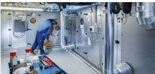
Prüfung des Luft befeuchters im Rahmen der Hygieneinspektion
