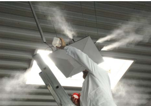
Wasserprobennahme zur Kontrolle der Keimbelastung des Befeuchterwassers
