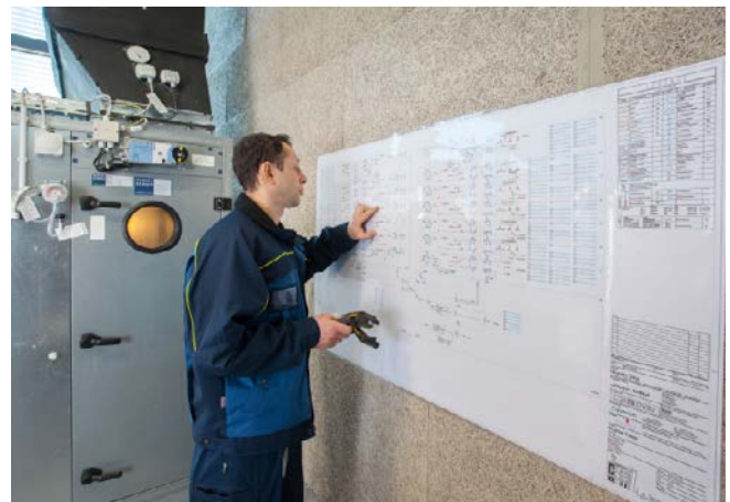
Bestandszeichnung (Revisionsplan) zur Orientierung in einer Lüftungszentrale
