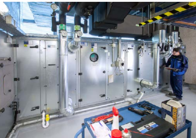
Überprüfung, ob die RLT-Anlage vollständig installiert ist
