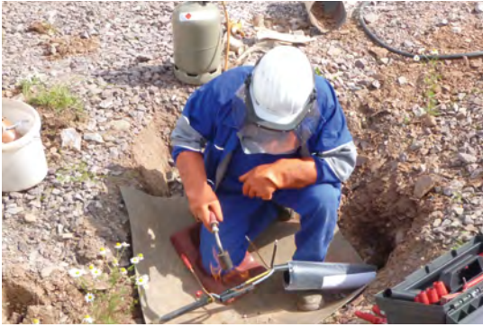
Arbeiten unter Spannung – Herstellen eines Hausanschlusses
