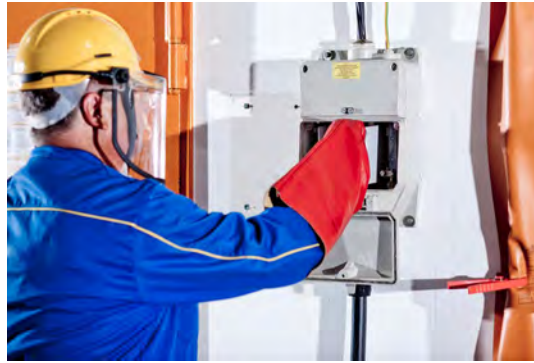
Ziehen eines NH-Sicherungseinsatzes
