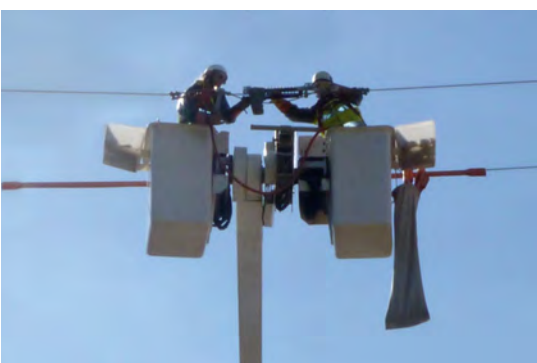
Arbeiten unter Spannung – Einbau von temporären Lasttrennschaltern
