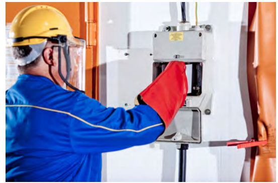
Ziehen eines NH-Sicherungseinsatzes
