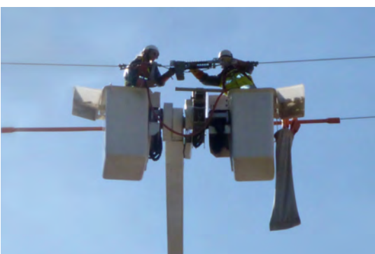
Arbeiten unter Spannung – Einbau von temporären Lasttrennschaltern
