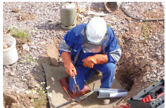
Arbeiten unter Spannung – Herstellen eines Hausanschlusses
