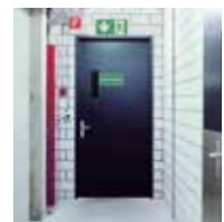
Verkehrswege und insbesondere Flucht- und Rettungswege müssen stets freigehalten werden!
