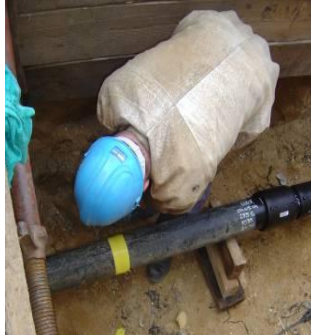
Kennzeichnung der Quetschstelle, um nicht an der gleichen Stelle nochmal abzuquetschen
