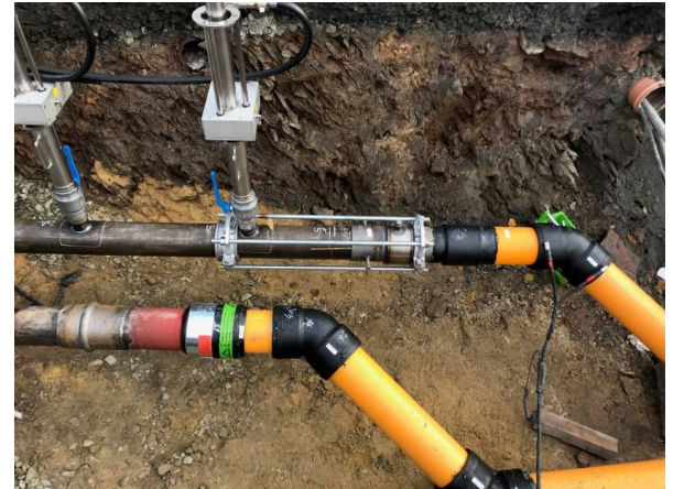
Beispiel für formschlüssige Sicherung des Muffenüberschiebers
