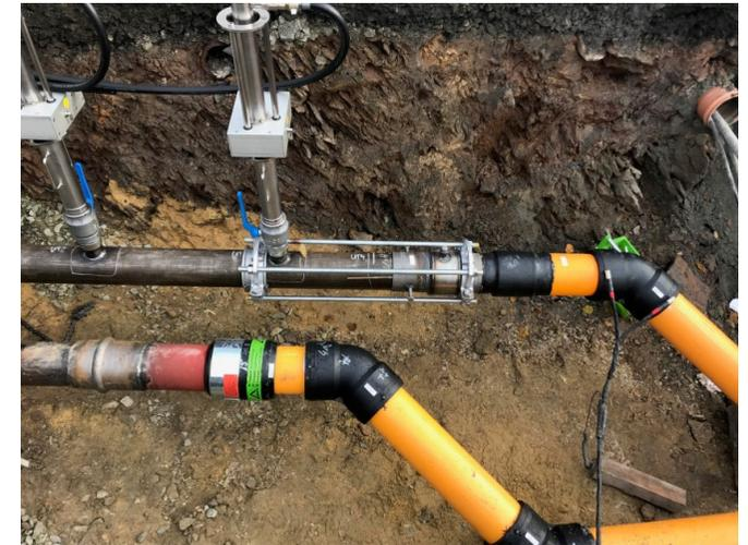
*Beispiel für formschlüssige Sicherung des Muffenüberschiebers*
