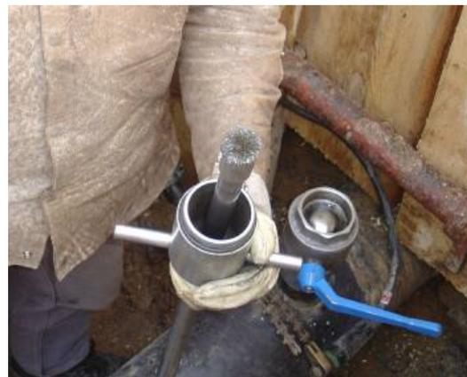
Spanentfernung nach dem Anbohren
