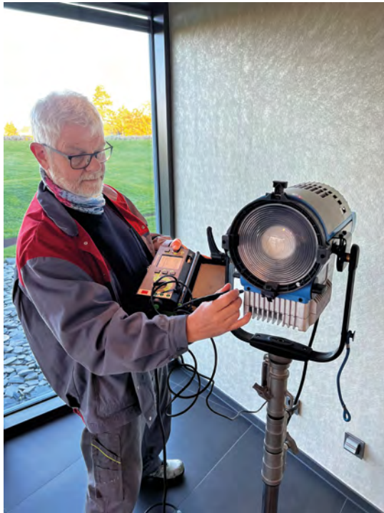
Prüfung einer Filmleuchte nach DIN VDE 0702 auf elektrische Sicherheit
