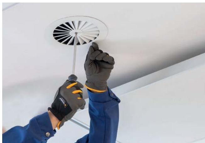
Einregulierung am Luftdurchlass
