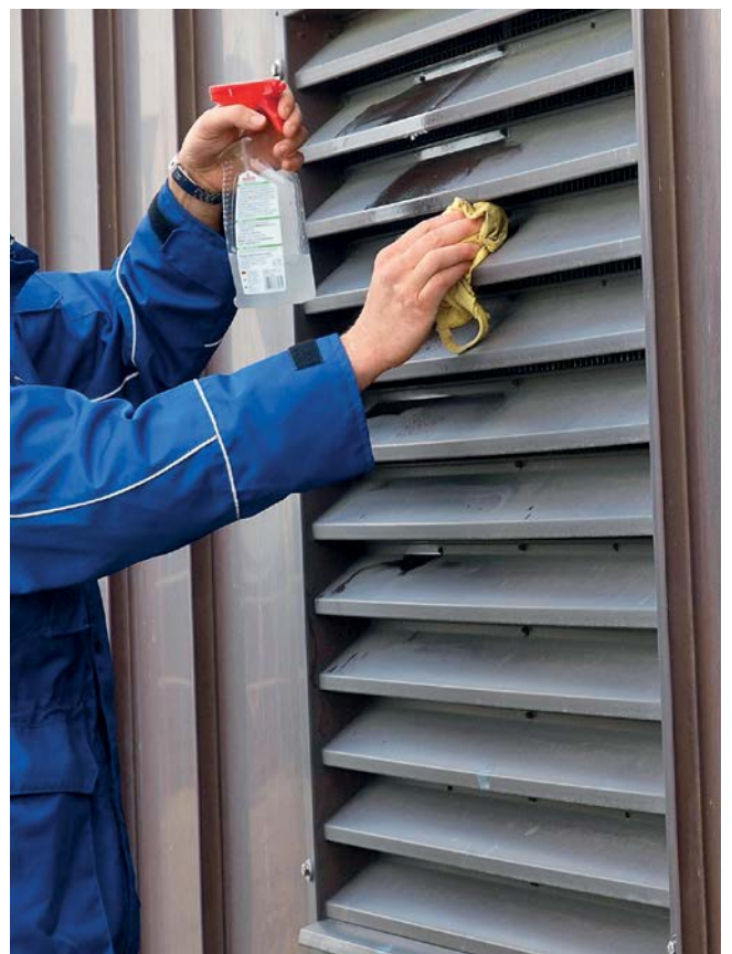
Reinigung einer Außenluftansaugöffnung
