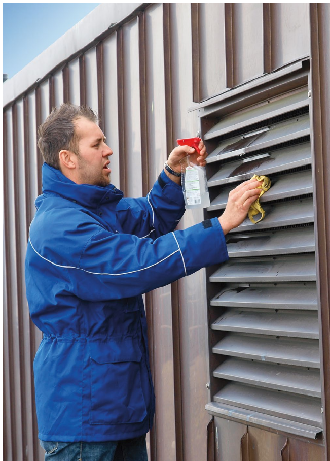
Reinigung einer Außenluftansaugöffnung
