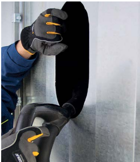
Reinigung einer Luftleitung
