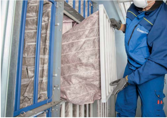
Ausbau eines gebrauchten Luftfilters
