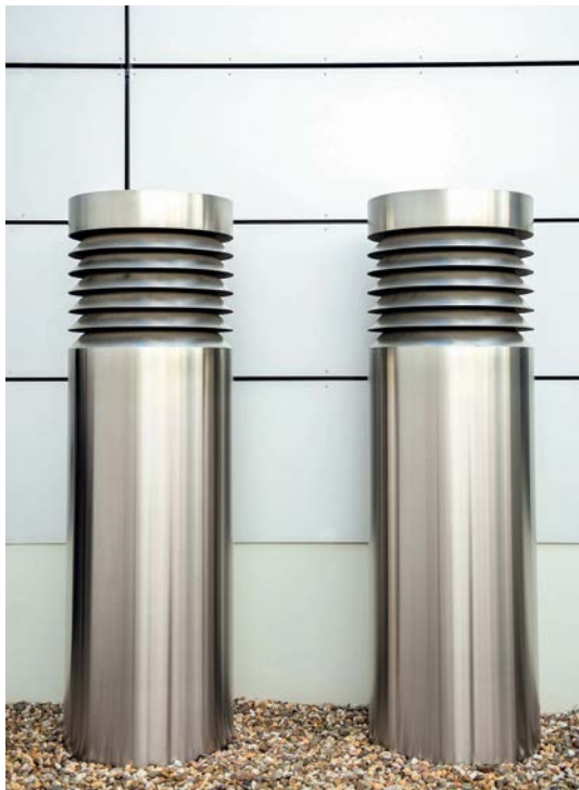
Außenluftansaugöffnung
