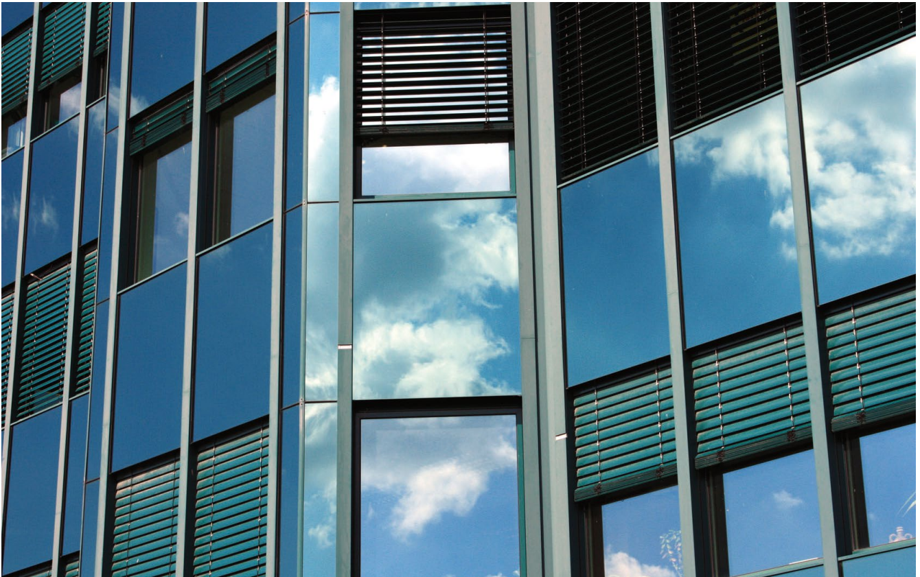
Sonnenschutzvorrichtung an einem Bürogebäude
