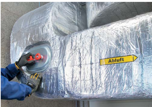
Öffnen einer Inspektionsöffnung zur Kontrolle der Luftleitung
