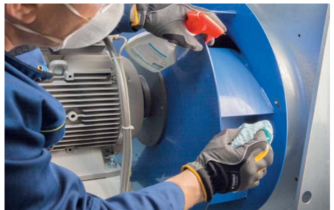
Reinigung eines Ventilators
