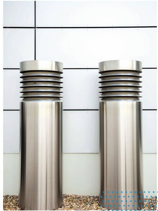
Außenluftansaugöffnung
