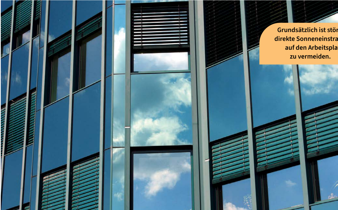
Sonnenschutzvorrichtung an einem Bürogebäude
