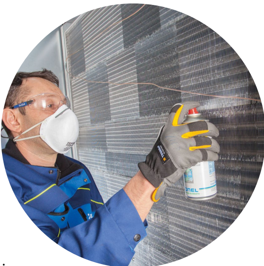
Desinfizieren eines Luftherzlers
