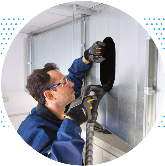
Reinigung einer Luftleitung
