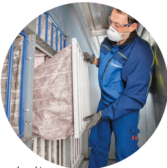
Ausbau eines gebrauchten Luftfilters
