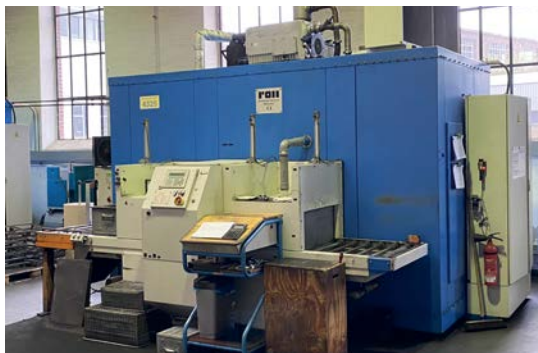
Abb. 7: Geschlossene Entfettungsanlage mit Tetrachlorethen (Per) als Reinigungsmittel
