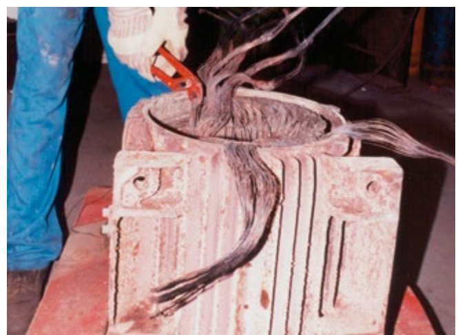
Abb. 4: Mechanisches Herausreißen alter Wicklungen
