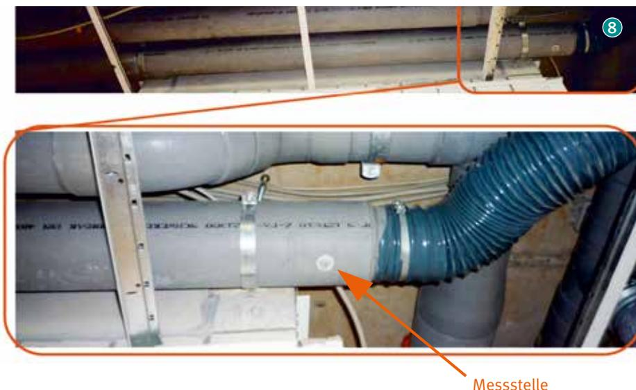
Bild 8 zeigt ein Beispiel einer ungünstig festgelegten Messstelle. Hier hätte die Messstelle deutlich weiter entfernt von dem gekrümmten flexiblen Schlauch gewählt werden sollen.
