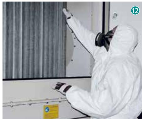
Geöffneter Abscheider: Prüfung der Filterelemente auf Beschädigung und Beseitigen von Ablagerungen bzw. Anbackungen im Abscheider.
