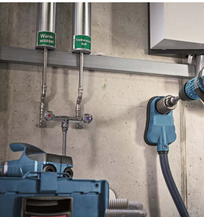
Abb. 2: Für das Dosensenken existiert das emissionsarme Verfahren BT 60.
