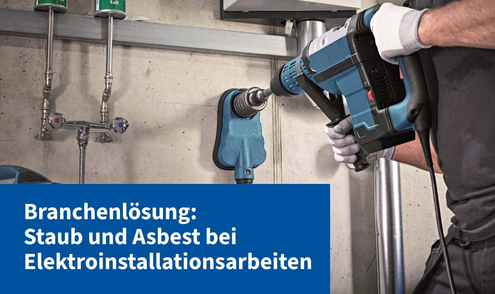
Abb. 1: Tätigkeiten wie das Dosensenken gehören zum Elektrohandwerk.
