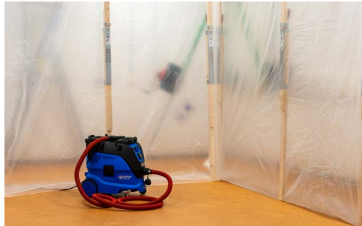
Abb. 8: Staubschutzwand aus Dachlatten und PVC-Plane
