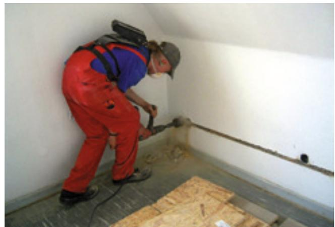
Perforado de huecos para instalación de tomas de corriente sin sistema de aspiración y generación de polvo claramente visible
