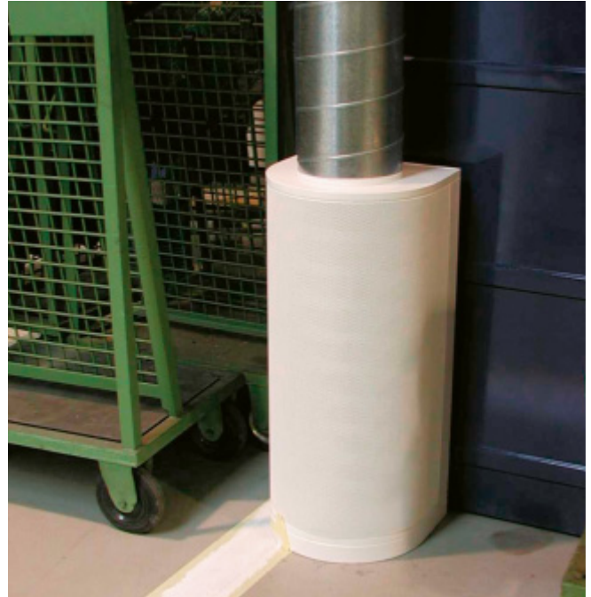
Abb.14: Zuluft durch Quellluftdurchlass
