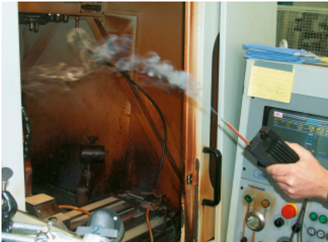
Abb. 22: Einregulierung des Abluftvolumenstromes mit Strömungsprüfröhrchen
