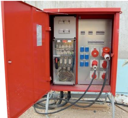
**14** „Strom kommt hier aus dem Baustromverteiler“, aber diesen sollten Sie sich genauer ansehen. Gehen Sie auf „Nummer Sicher“. Bevor Sie hier den Stecker eines elektrischen Betriebsmittels anschließen, kontrollieren Sie oder fragen Sie nach, ob der Baustromverteiler mit einer 30-mA-Fehlerstrom-Schutzeinrichtung (0,03 A) wo notwendig ausgerüstet ist.
