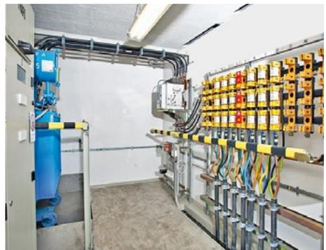
**13** Glasabdeckungen in Sicherungs-Schraubkappen verhindern das Berühren aktiver Teile. Achten Sie besonders bei Altanlagen darauf, dass dieser Schutz gegen direktes Berühren vorhanden ist!
